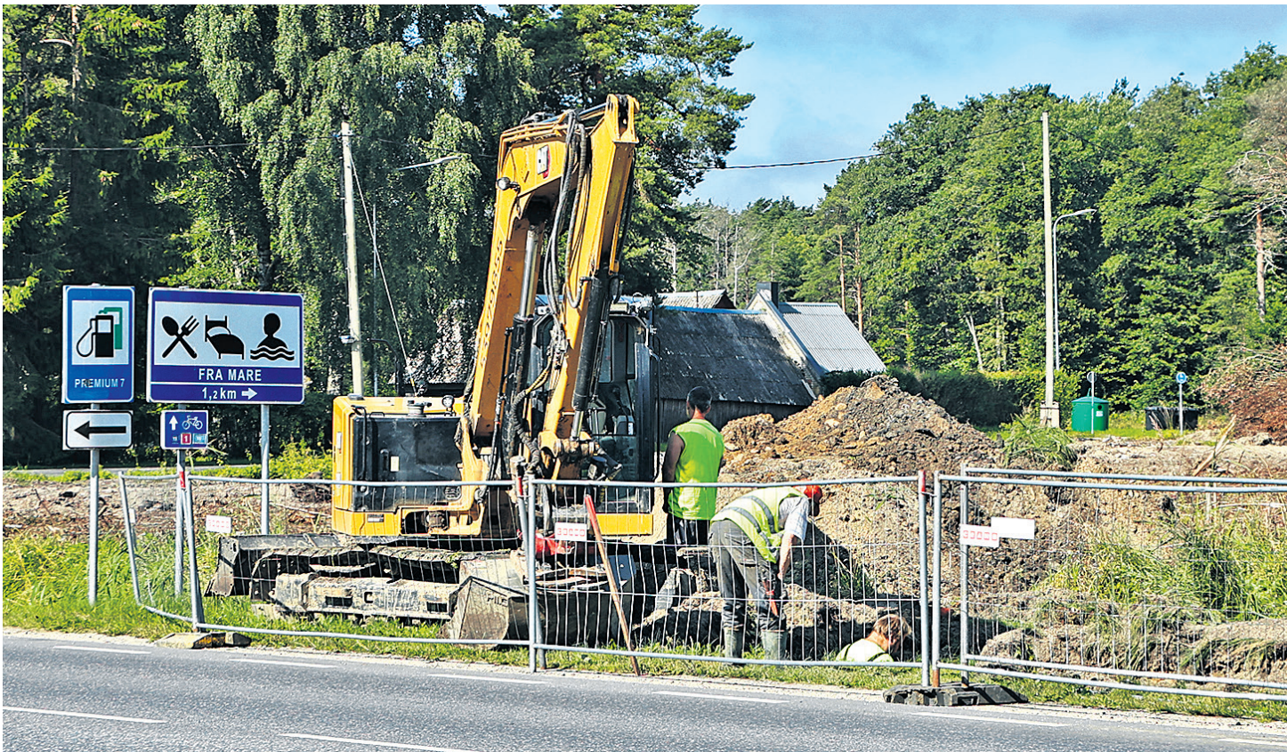
Lao tänava ja Kiltsi tee äärde plaanitava ärikvartali ehitus algas kommunikatsioonitrasside rajamisega.
