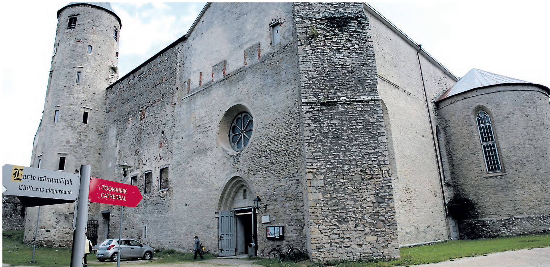
Haapsalu toomkiriku võlvid kaetakse soojustusega ning ristimiskabel ja käärkambrid saavad soojustatud katuse.
