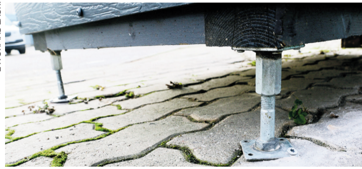
Toidukapi kipakad jalad on maa külge kinnitatud ühe kruviga.
