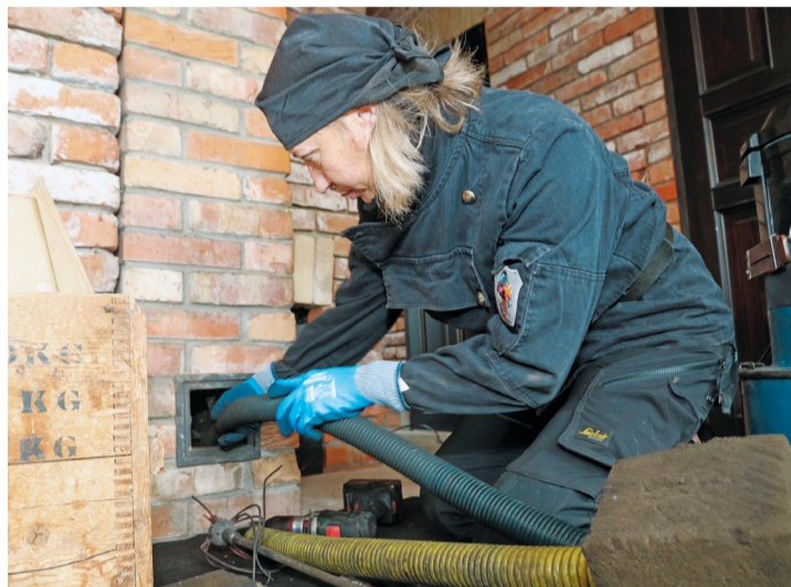
Korstnapühkija Kaie Krüütsi üks olulisimaid töövahendeid on tolmuimeja. Tupp ei satu ühtegi tahmakübet.
