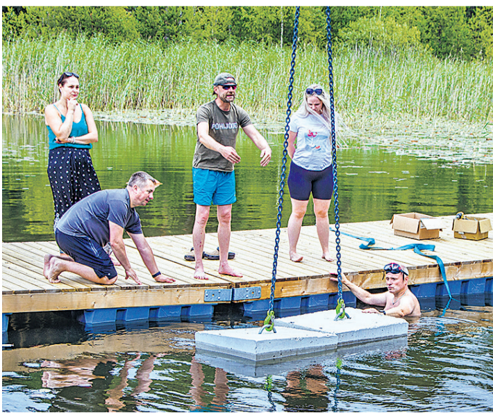
Palivere uut ujumissilda hoiavad vee all paigal jõepõhja uputatud betoonploki- ANDRA KIRNA
