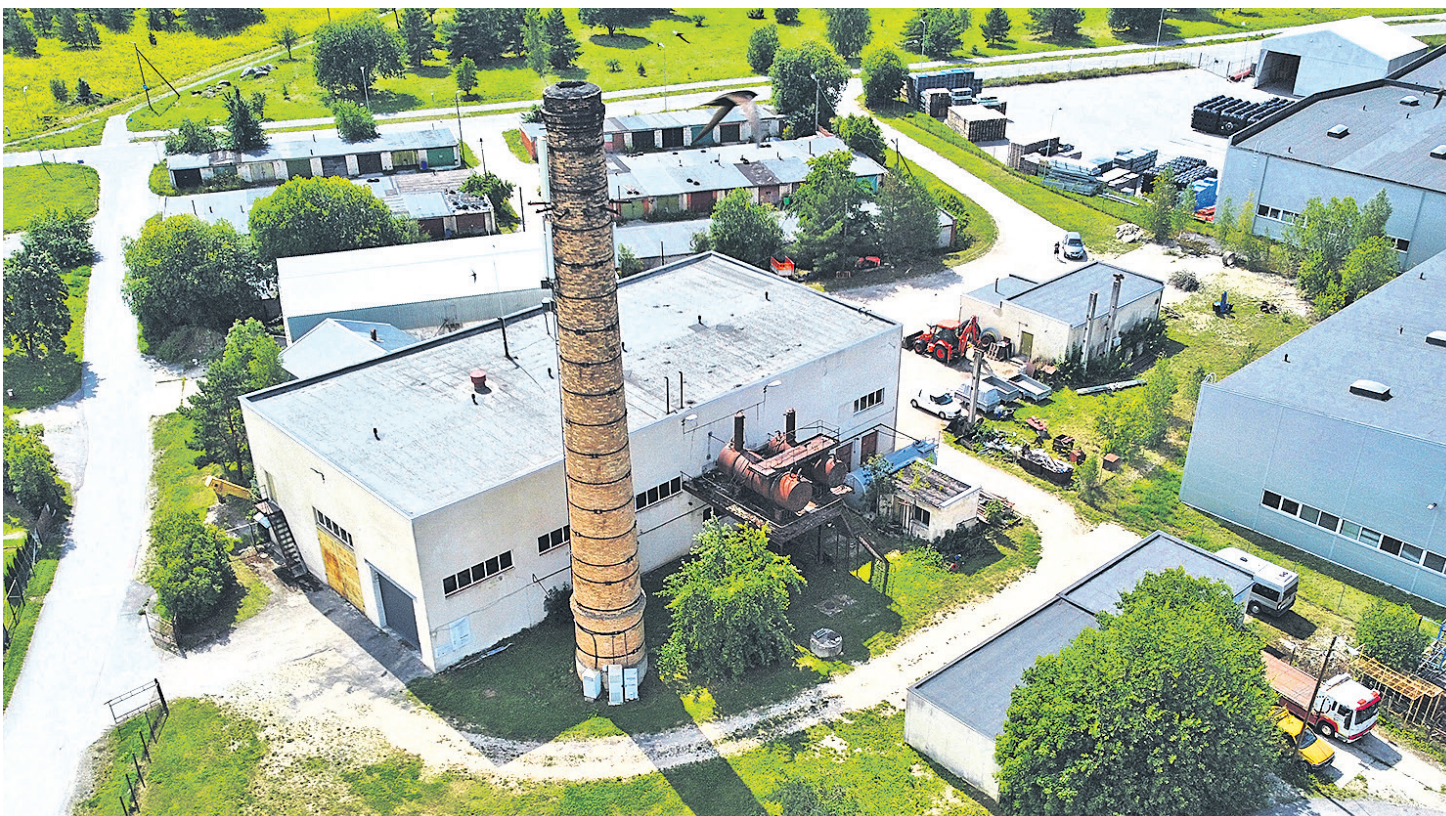
Taebpla katlamaja korsten läheb remondi käigus lammutamisele.
